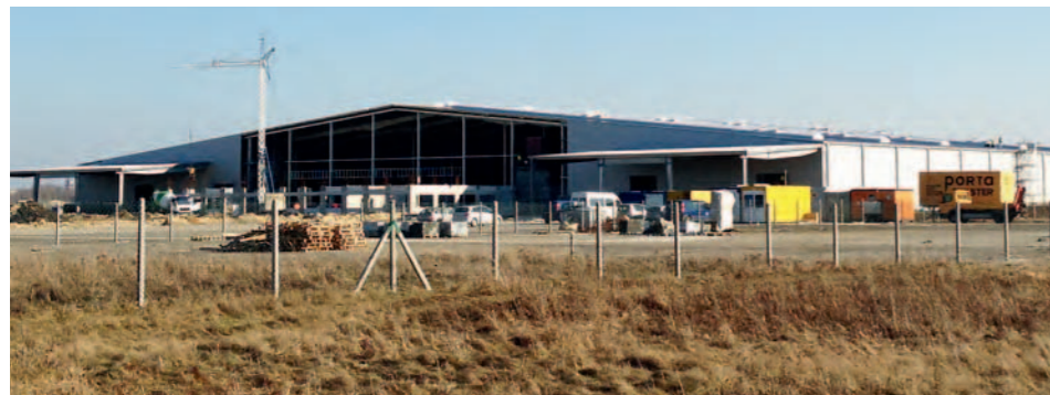
Hallenbau der PX Kabel GmbH
